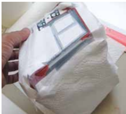
Alle nicht zu lackierenden Flächen müssen sorgfältig abgedeckt werden
